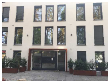
6 Familienhaus – Neubau Dortmund Schüren
